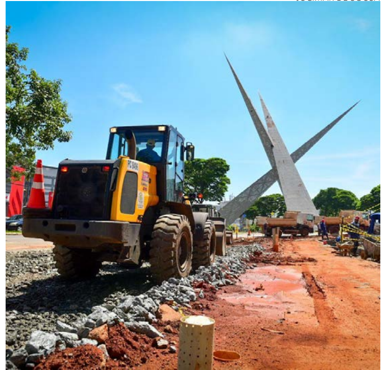
Vistoria de obras de infraestrutura ocorreu na manhã de sexta-feira
